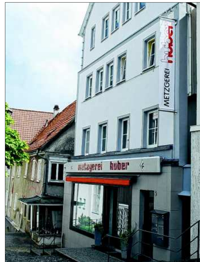
Auch die Fassade wurde saniert.
